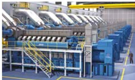
«Puissance 10». Une solution modulaire de micro-réseau d'énergie incorporant des moteurs Bergen de 10 MW, des générateurs Marelli et la technologie de conditionnement d'énergie Piller pour un déploiement rapide de l'énergie.
