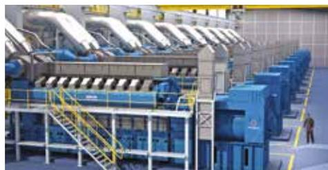
*"The Power of 10". Una soluzione modulare per le Microreti che incorpora un motore Bergen Engines da 10MW, generatori Marelli & la tecnologia di condizionamento dell'energia di Piller, per la rapida distribuzione di energia su larga scala.*
