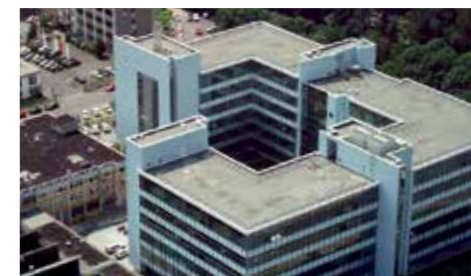
Das Senefelderhaus, die ehemalige Zentrale der Manroland AG, wurde saniert und an die Bundespolizei vermietet.
