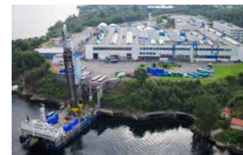
Das Werk Bergen Engines AS in Norwegen.
